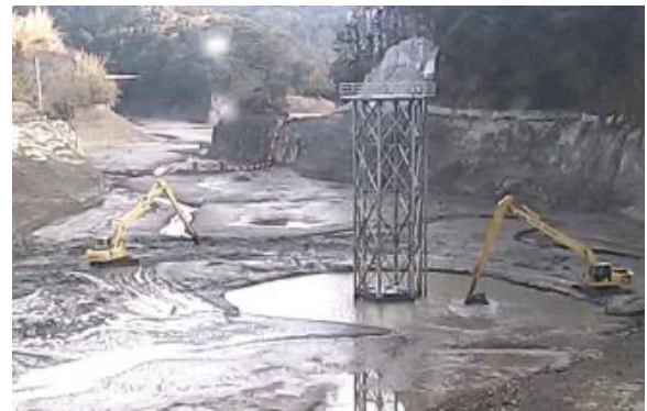
Fig. 3 現地実証ダムでの浚渫工事の現況 Status of dredging work at the demonstration dam
